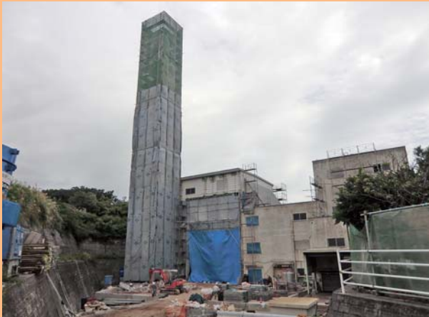
島尻環境美化センターごみ焼却施設の解体工事(6P) (一般廃棄物処理施設建設準備室)
