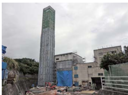
△ (解体工事：H27.11.4撮影) △
