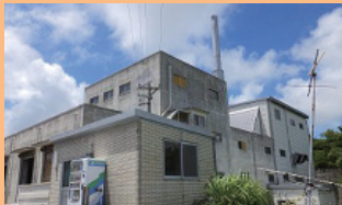
（島尻環境美化センターごみ焼却施設の解体前のようす）
