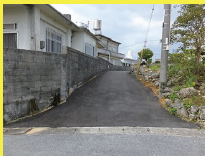
集落道路アスファルト舗装
