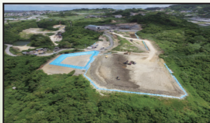
▲沈砂池工事完了 (H28.6 月)
