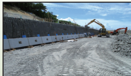
▲補強土擁壁工事 (H28.6 月)
