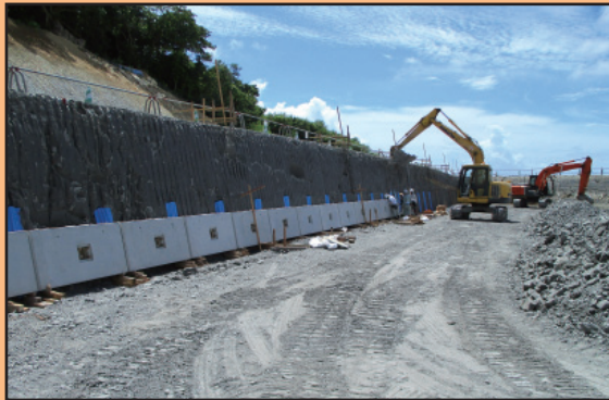
最終処分場内側の補強土擁壁工事（6P） （施設課）
