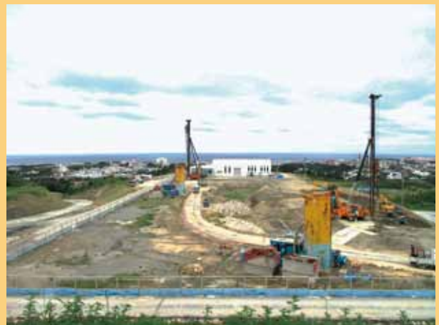
最終処分場建設B棟建設状況＝施設課…8p
