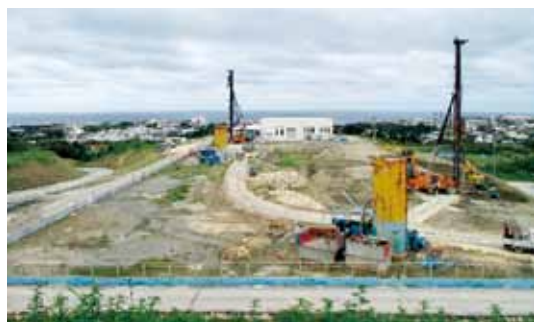
地盤改良工事
