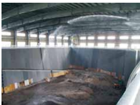
A棟埋立状況（散水中）
