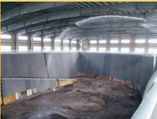
最終処分場建設A棟埋立状況＝施設課…8p
