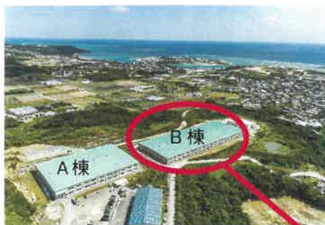
美らグリーン南城（最終処分場）
