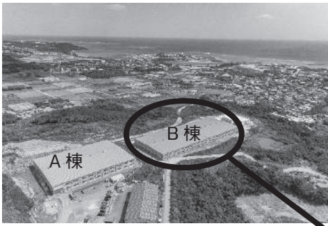
美らグリーン南城（最終処分場）
