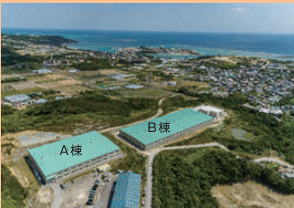
美らグリーン南城（最終処分場）
