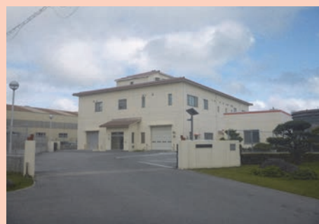
汚泥再生処理センター
