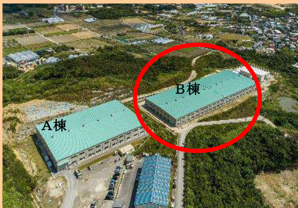
最終処分場建設事業 (工事完了)
