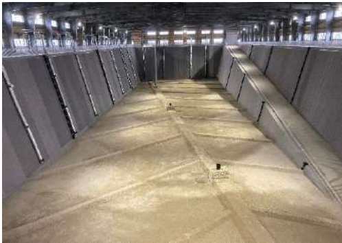
B棟建屋内
