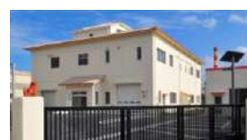
汚泥再生処理センター(東部)
